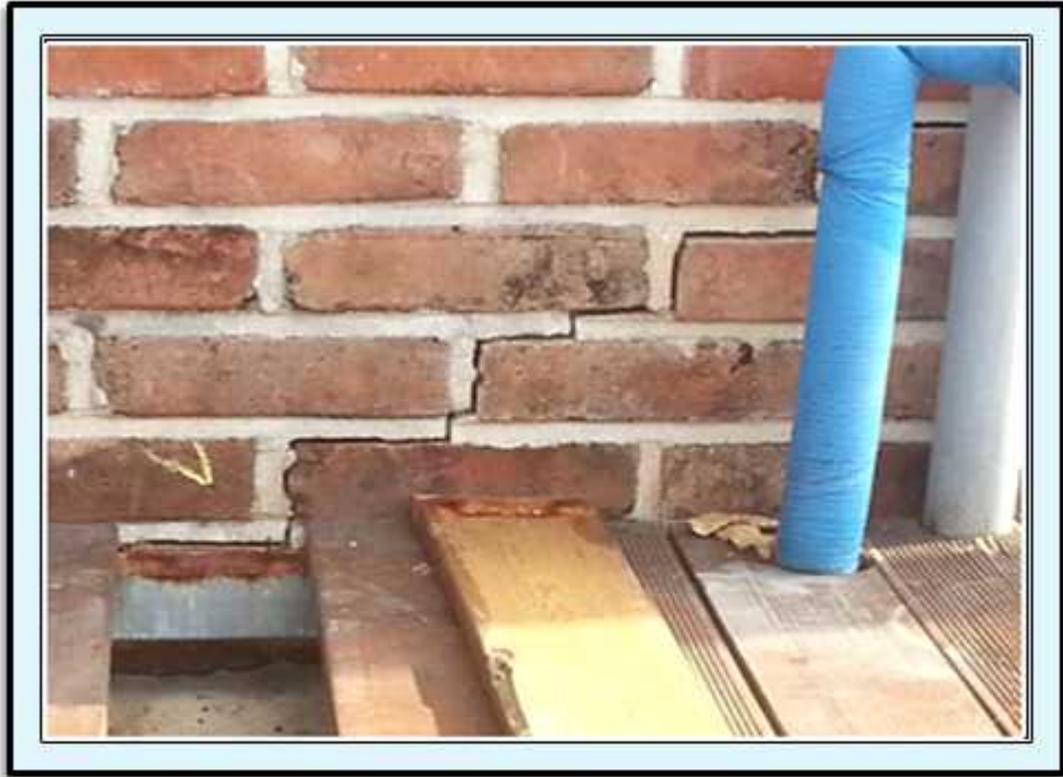
공사 내용 시공 전
