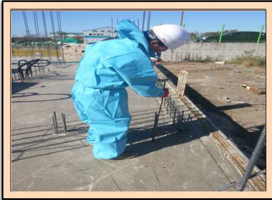
공사 내용 주 입
