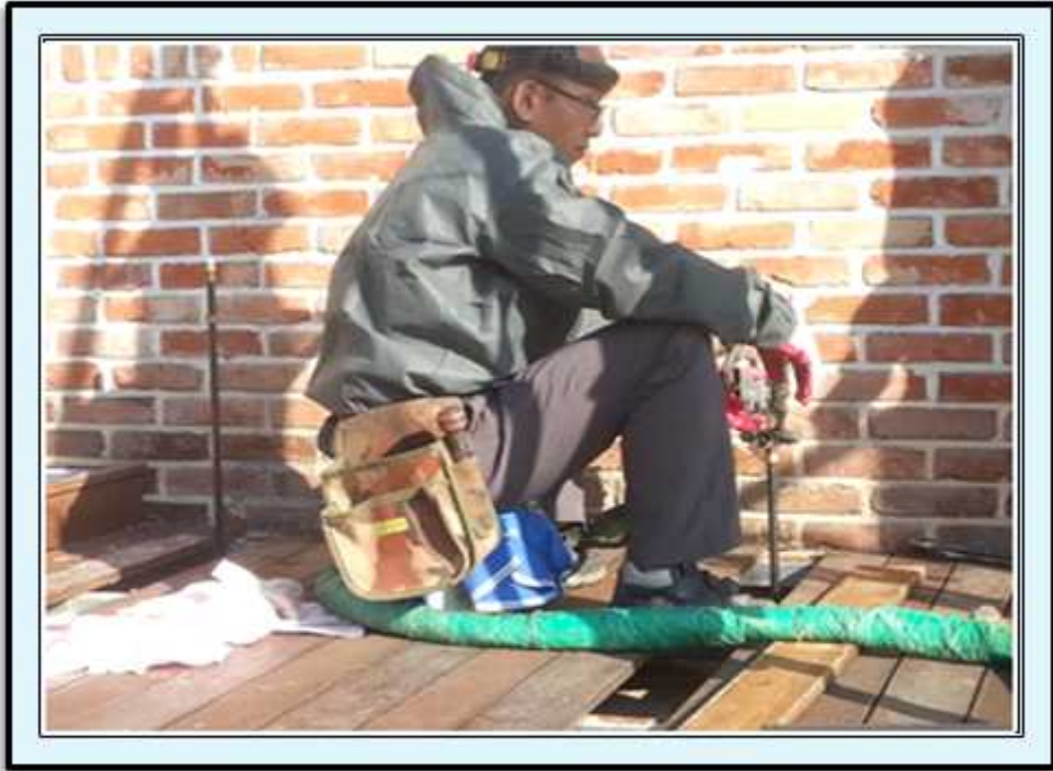
공사 내용 침하구조물 복원공사 중
