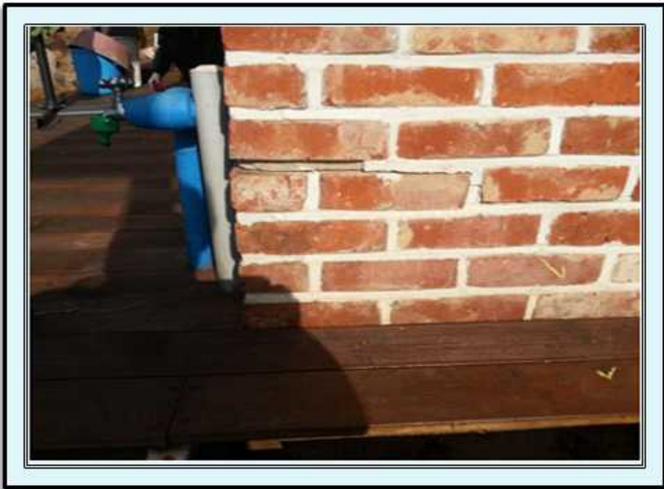
공사 내용 시공 전
