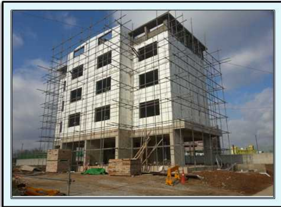
공사 내용 골조 완료
