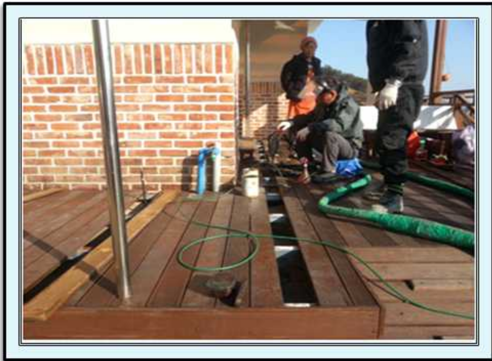
공사 내용 침하구조물 복원공사 중
