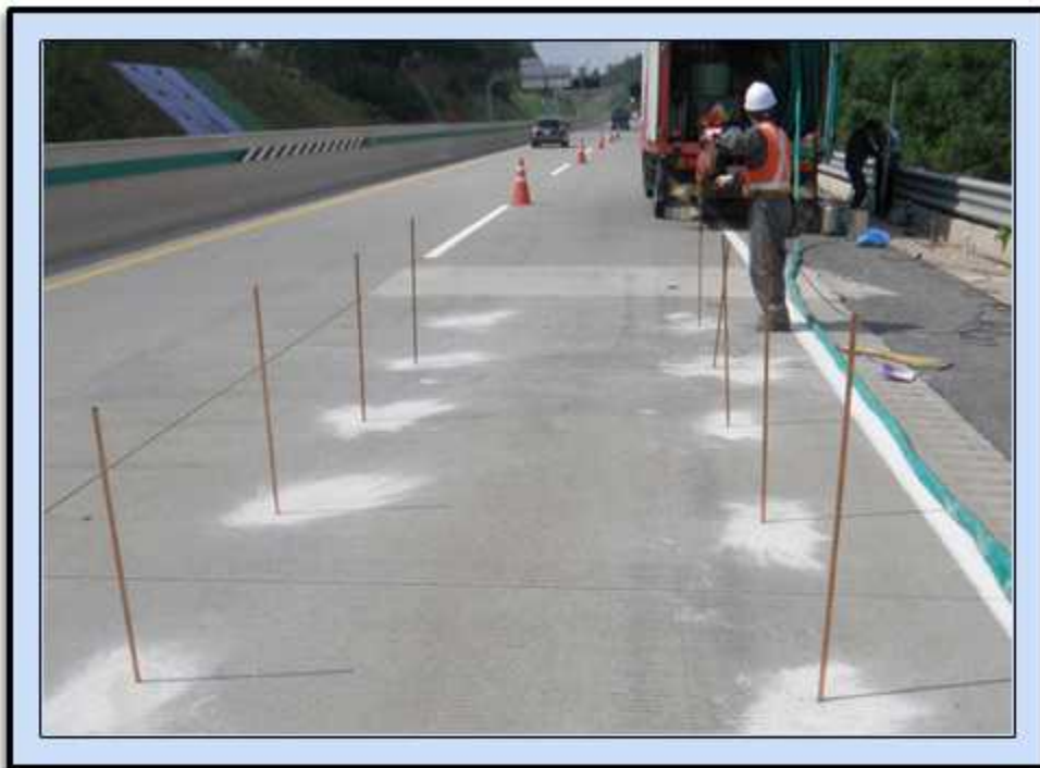
공사내용 주입관 설치(동파이프 Φ16)
